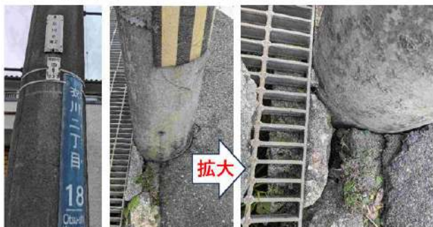
掘れている電柱の根元
