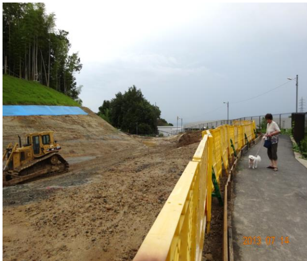
2. 工事の開始時の掘削状況
